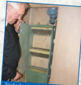
Technik sinnvoll eingesetzt: Vom Kotband in den Trichter und von da aus mit Saugkraft in die unten stehende Tonne. Rasche und umweltfreundliche Entsorgung der Hinterlassenschaften. Selbst wenn die Kotbänder bis nahe an den Boden gehen, findet sich eine Absaugmöglichkeit.
