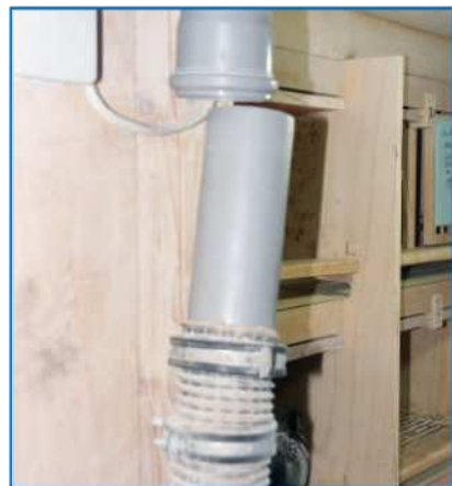
Der Ansaugstutzen für den Staubsauger- schlauch. Alle zwei bis drei Meter wird ein solcher Stutzen installiert.
